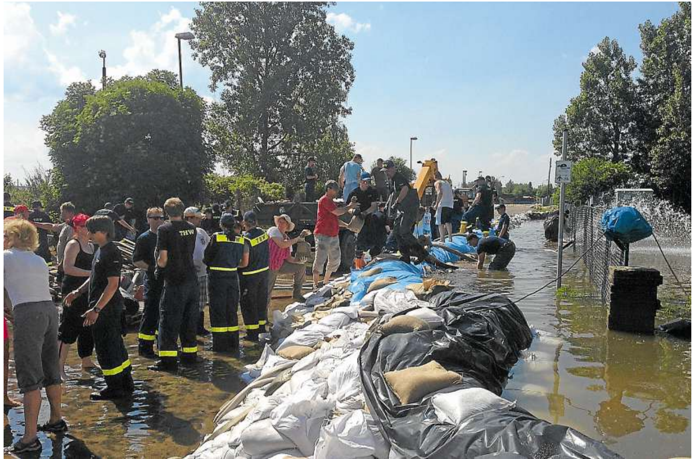
Das THW-Einsatzteam aus Münster hilft beim Einsatz im Katastrophengebiet bei Magdeburg gemeinsam mit vielen anderen Kräften einen Damm aus Sandsäcken aufzutürmen.
